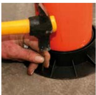
Una volta creato il sottofondo (platea, magrone) collocare in opera la base inferiore in PP modulare per il fissaggio dei tubi/colonna.
