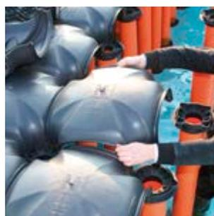
Posare il tubo in PE per semplice incastro e completare la colonna portante con la base superiore.
