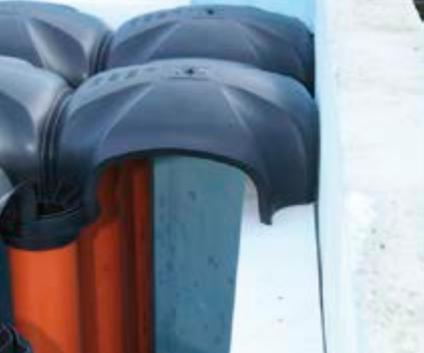
*Il sistema di posa del **New K-due** è analogo al sistema di posa del cassero Kappax e grazie alla facilità di assemblaggio degli elementi permette di ridurre i tempi di manodopera di quasi l'80%.*
