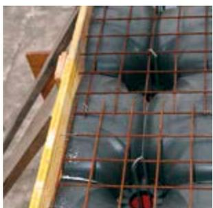
Posa della rete elettrosaldata e delle forchette di armatura delle colonne di sostegno.
