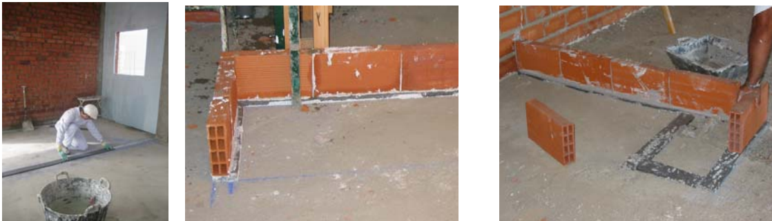
Detalle del replanteo y ejecución de particiones con bandas
