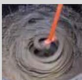
Amasar\* **weber.xerm 859 F** con 6 litros de agua limpia por saco de 25 kg con un batidor eléctrico lento (500 rpm) hasta obtener una masa homogénea y exenta de grumos.
