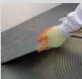
Colocar las baldosas y presionarlas hasta conseguir el aplastamiento de los surcos del mortero cola. Comprobar periódicamente la pegajosidad de la pasta levantando la baldosa previamente colocada.
