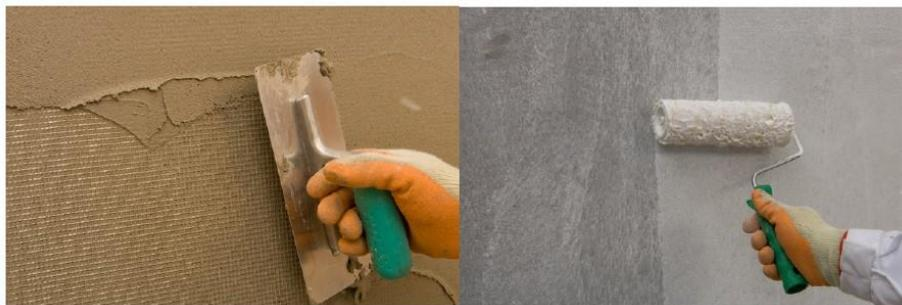
Cuando la última capa de **weber.therm base** esté completamente seca, mínimo 24 horas después de su aplicación en función de las condiciones meteorológicas, se aplica **weber CS plus**, imprimación de fondo y regularizador de la absorción. Este producto se extiende con un rodillo o una brocha en 2 manos cruzadas, y debe presentar una coloración similar a la del revestimiento final. Es importante que esta capa sea uniforme en términos de aplicación.
