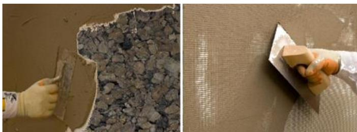
No aplicar nunca la malla directamente sobre el material aislante. En las juntas de la malla deberá existir una superposición mínima de 10 cm, y esta deberá envolver las aristas donde existan **weber.therm perfil esquinero PVC**.
