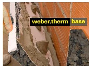
Las placas deben ser colocadas en posición horizontal en filas sucesivas, de abajo a arriba, a rompe-juntas en relación con la hilera anterior. Del mismo modo en las esquinas, los extremos de las placas deberán ser alternados, para mejorar el trabamieto del sistema.
