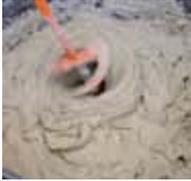
Amasar **weber.col yeso** con 6 - 8 litros de agua limpia por saco, manualmente o con un batidor eléctrico lento (500 rpm), hasta obtener una masa homogénea.
