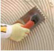
Dejar reposar la mezcla unos 2 minutos y extender sobre el soporte en paños pequeños (máximo 2 m<sup>2</sup>) y peinar con una llana dentada para regularizar el espesor de la aplicación.
