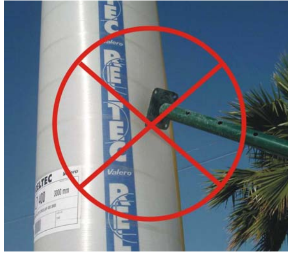
No aplicar el puntal directamente sobre el encofrado
