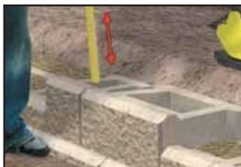
En cada capa de 200 mm (8 pu), compacte los alveolos del bloque con el mango de una pala, y la zona posterior de los mismos con una bandeja vibradora según los procedimientos descritos en este manual.
