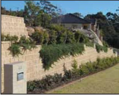
Es a menudo estéticamente más agradable reemplazar un muro alto por dos o más muros en terraza más pequeños. Los muros aterrazados pueden actuar como sobrecargas y crear una inestabilidad global, es por tanto necesario disponer de refuerzo. Siempre consúltelo a un ingeniero capacitado para este tipo de estructuras.
