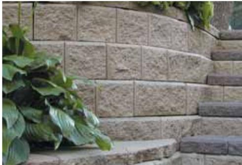
Para conseguir una curva más suave se puede cortar algún bloque o utilizar medios bloques, esto facilitará la construcción de la curva.
