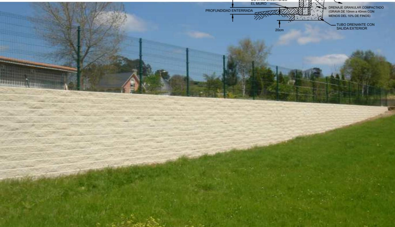
Cuando las alturas de los muros y las condiciones de los suelos excedan el potencial de gravedad, se integrará la geomalla para proporcionar la solidez adicional requerida. Mediante capas de geomalla a distancias específicas de recubrimiento detrás del muro, se desarrollarán fuerzas de roce entre suelo y geomalla para formar una masa unificada de suelo. Esta masa del suelo crea una resistencia adicional necesaria para compensar la presión de la pendiente retenida.
