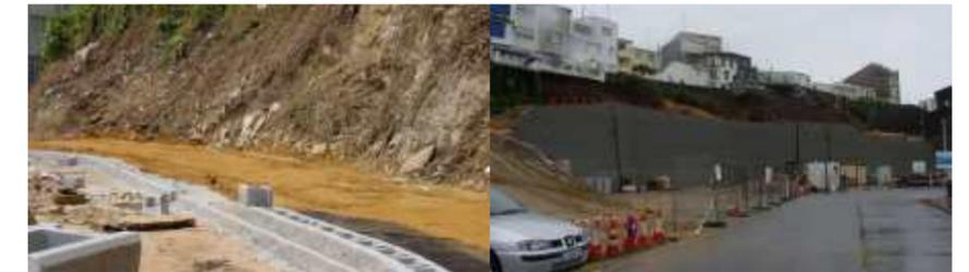
En todo muro de contención es de vital importancia la correcta evacuación de las aguas para evitar su acumulación y el consiguiente aumento de cargas, es por ello que se fue integrando tubería drenante a diferentes niveles en el trasdós del muro relleno de grava; del mismo modo se realizó un canal superior que recoge las aguas del mirador, evitando así las chorreras en el frente del muro.
