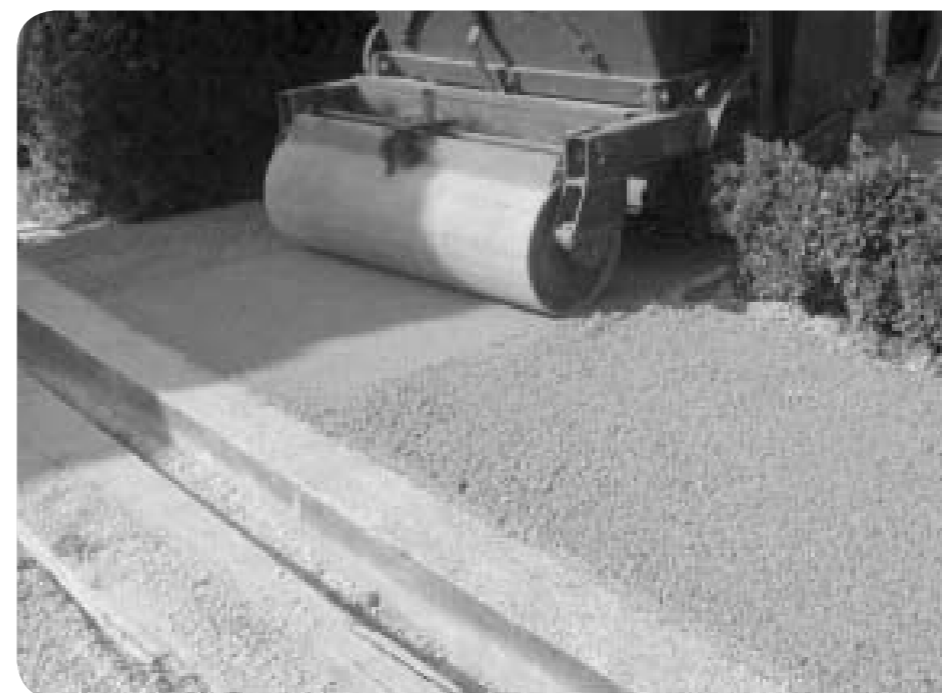
Foto 5. Iguale la superficie y compacte la arena tratada con un compactador de rodillo.
