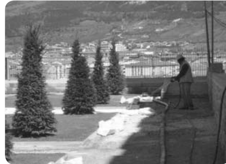
Foto 1. Humedezca el soporte sin encharcar la superficie.
