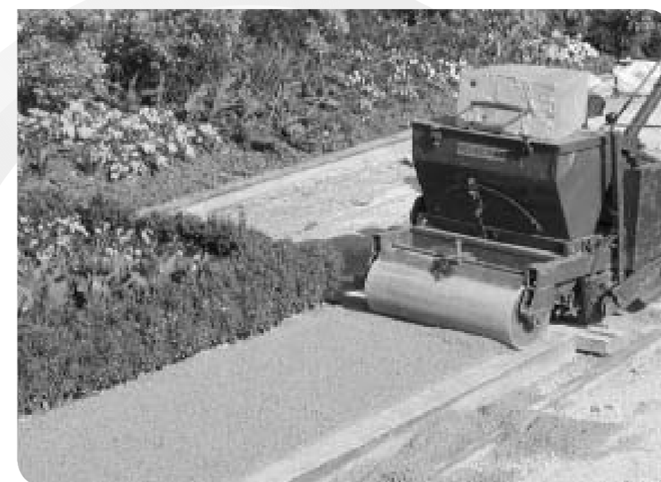
Foto 6. Detalle de subida a acera mediante rampa con tabloncillos.
