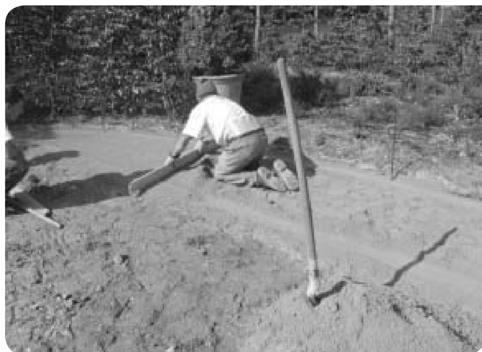
Foto 3. Nivele con regla la arena tratada.
