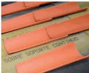
Colocación de las tejas canales
