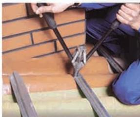
Este sistema es adecuado para cualquier modelo de teja con tacón. Consiste en la fijación mediante remaches de un rastrel metálico a la placa y posterior colocación de las tejas sobre el rastrel.
