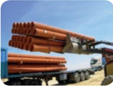
*Fig. 1 Descarga con pinzas*
