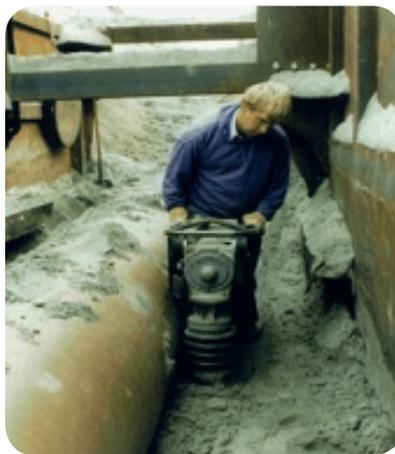
*Fig. 19 Compactación lateral de la zanja*
