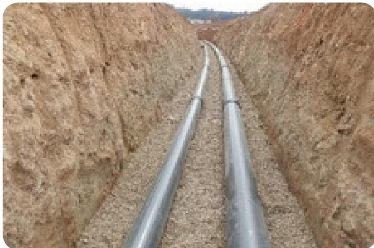
*Fig. 10 Rasanteo y anchura de la base de la zanja*
