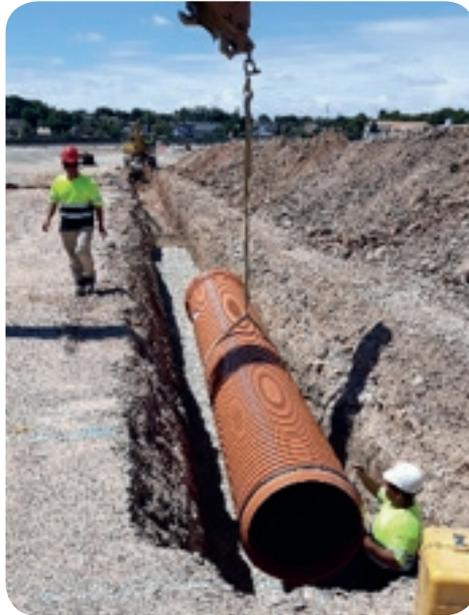
*Fig. 13 Manipulación tubos con eslinga*
