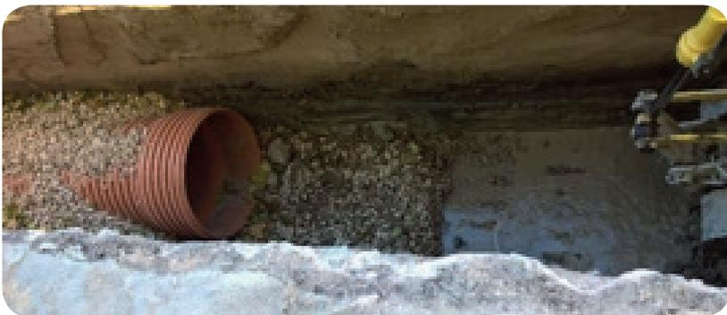
*Fig. 11 Extendido de la cama de apoyo con nivel freático*
