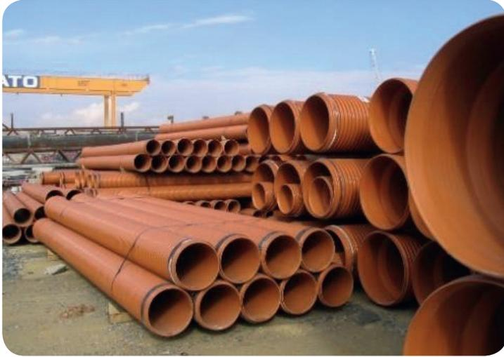
*Fig. 3 Apilado de tubos en obra*
