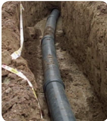
Fig. 15 – Montaje con traza curva
