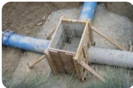
Fig. 21 Anclajes en codos y tes
