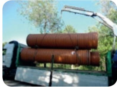
*Fig. 2 Descarga con eslingas*
