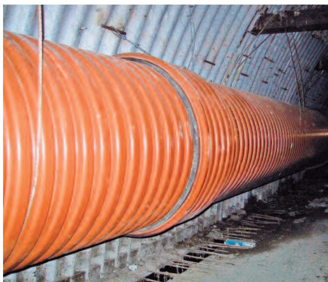
INSTALACIÓN DE TUBERÍAS adecuada SANECOR® EN GALERÍA Y EN ZANJA.
