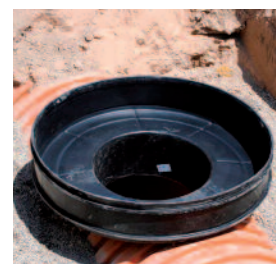
INSTALACIÓN DEL CUERPO CON BASE DE REGISTRO.
