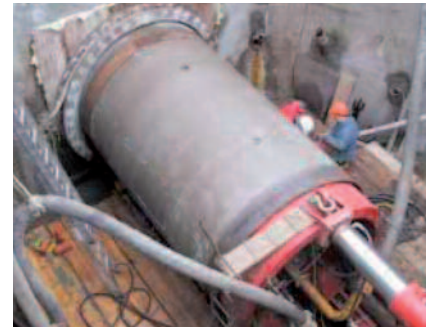
Hormigón polímero (tuberías de hinca).
