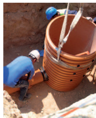
INSTALACIÓN DE TUBERÍAS AL CUERPO DEL POZO.
