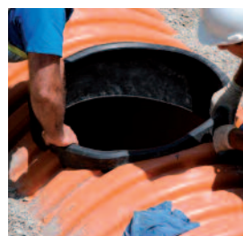
INSTALACIÓN DEL CUERPO CON BASE DE REGISTRO.
