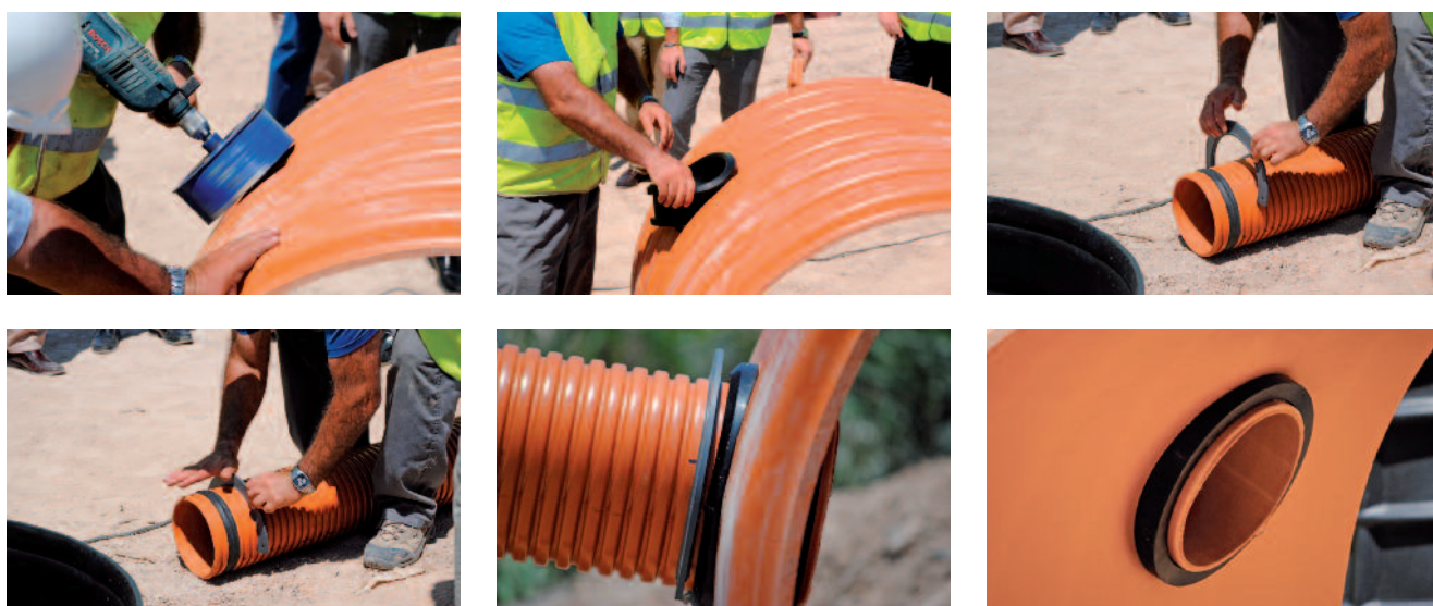
SECUENCIA DE MONTAJE DE PIEZA "DIADEMA" PARA EL TOPE DE LAS ACOMETIDAS adecuada SANECOR®.
