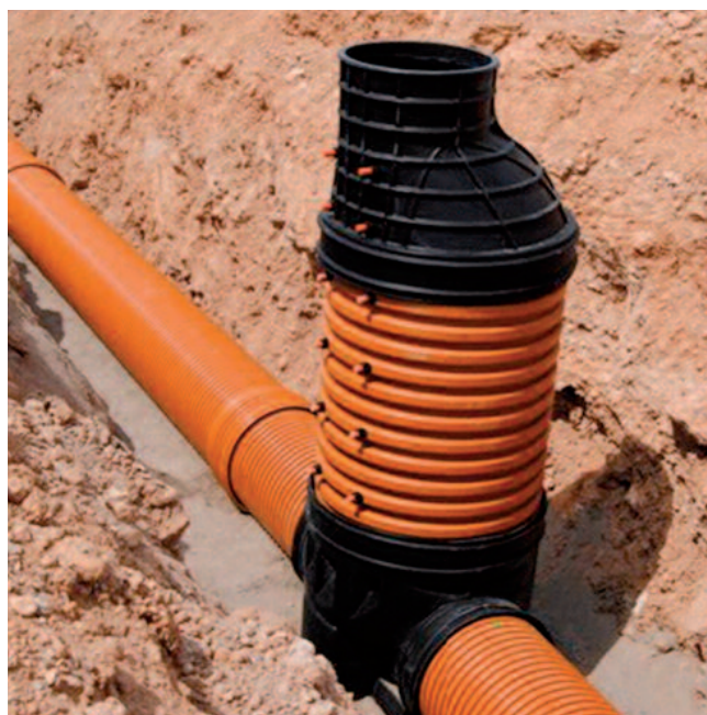
INSTALACIÓN DE PIEZA ENTRONQUE DE PASO TOTAL.
