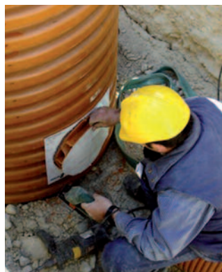
PROCEDIMIENTO DE PERFORACIÓN DE TALADROS PARA INSERCIÓN DE CLIPS ELASTOMÉRICOS.
