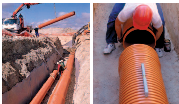
A LA IZDA., MONTAJE DE TUBERÍAS adecuada SANECOR® CON MEDIOS MECÁNICOS DISCRETOS (DIÁMETROS MEDIOS Y GRANDES). A LA DCHA., UNIÓN MANUAL (DIÁMETROS PEQUEÑOS).
