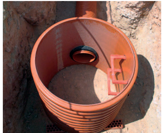
HORMIGONADO DEL FONDO DEL POZO. 1ª FASE.
