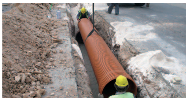
MANIPULACIÓN EN OBRA DEL TUBO adequa SANECOR® .
