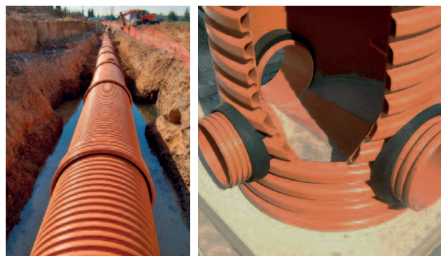
EL CUERPO DEL POZO adecuada SANECOR® SE FABRICA A PARTIR DE TUBERÍA adecuada SANECOR® SN8.
