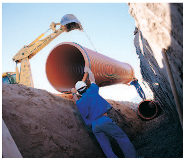
INSTALACIÓN DE TUBERÍAS adecuada SANECOR® EN GALERÍA Y EN ZANJA.
