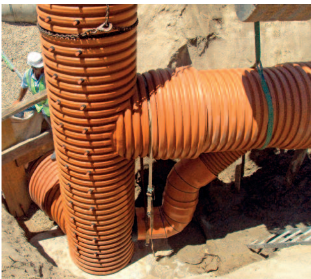
POZOS DE RESALTO CON EL SISTEMA DE POZOS adecuada SANECOR® (A LA IZDA. TIPO MADRID).
