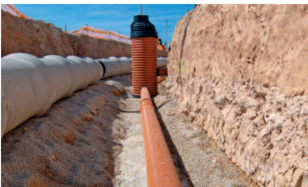
COLECTOR Y POZOS adequa SANECOR® PARA AGUAS RESIDUALES JUNTO A COLECTOR DE PLUVIALES EN HORMIGÓN.
