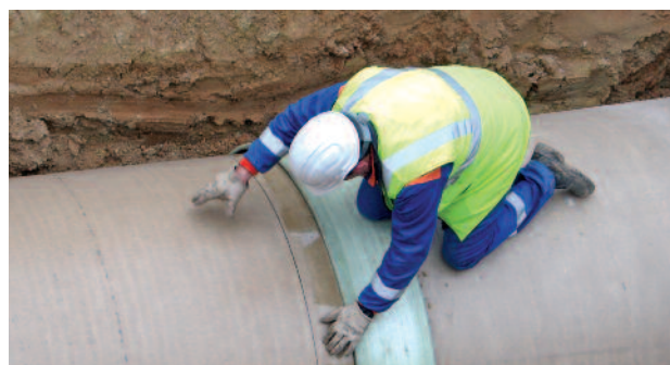
UNIÓN POR MANGUITO EN TUBERÍAS DE PRFV DE GRAN DIÁMETRO.
