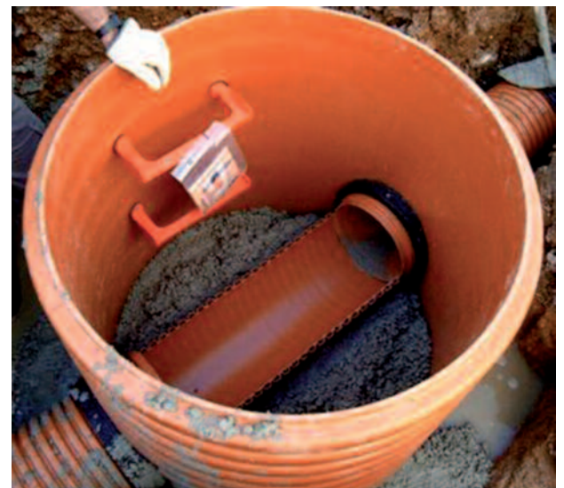
HORMIGONADO DEL FONDO DEL POZO. 2ª FASE.
