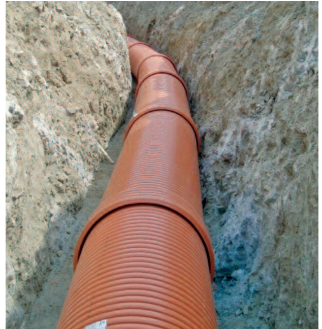
TUBERÍA adecuada SANECOR® DE 1200 mm CON DESVIACIÓN ANGULAR.
