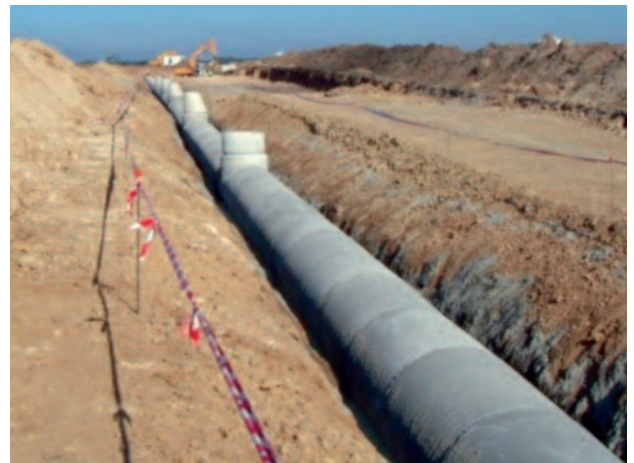
COLECTOR DE HORMIGÓN ARMADO.
