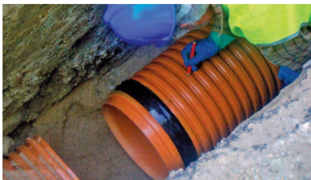
CONEXIÓN MANUAL DE TUBERÍA CORRUGADA.
