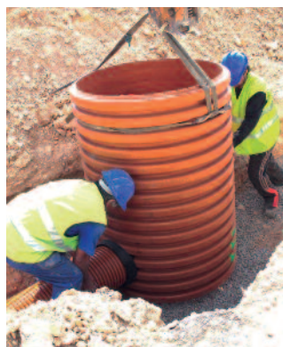
INSTALACIÓN DE TUBERÍAS AL CUERPO DEL POZO.
