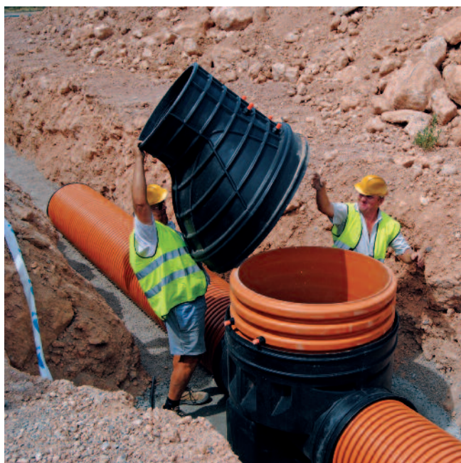
INSTALACIÓN DE PIEZA ENTRONQUE DE PASO TOTAL.
