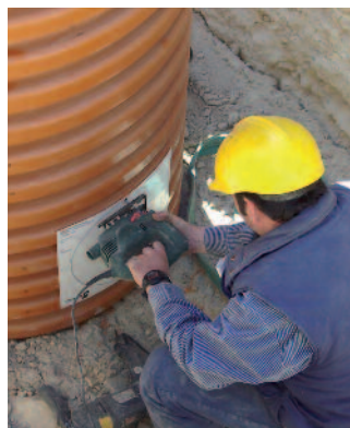
PROCEDIMIENTO DE PERFORACIÓN DE TALADROS PARA INSERCIÓN DE CLIPS ELASTOMÉRICOS.
