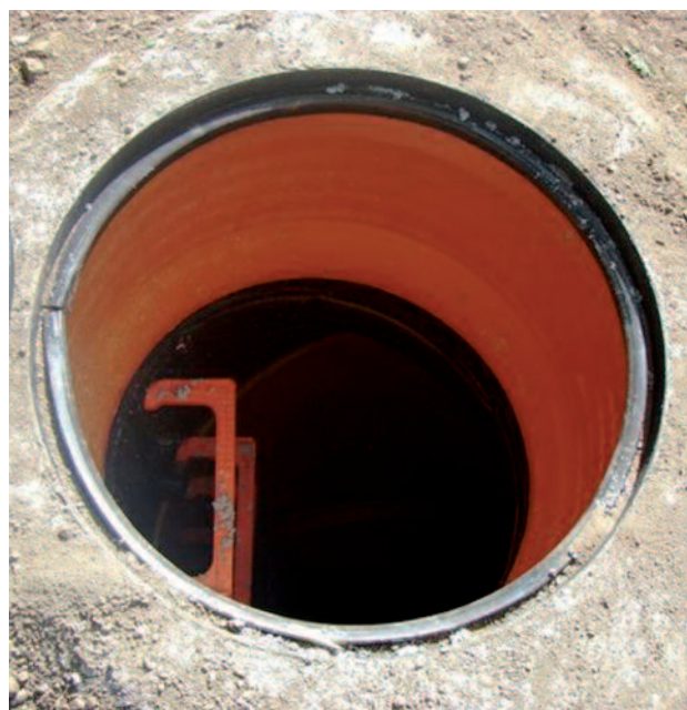
CORONACIÓN DEL POZO.
