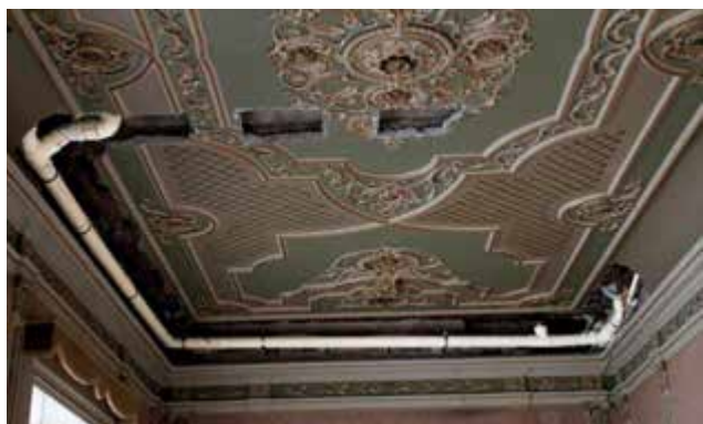
Rehabilitación de Palacete en Plaza Manises, Valencia
